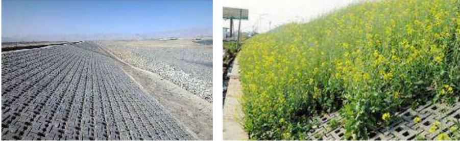
图 6-33 生态连锁块护坡建成初期 生态连锁块护坡植生后
