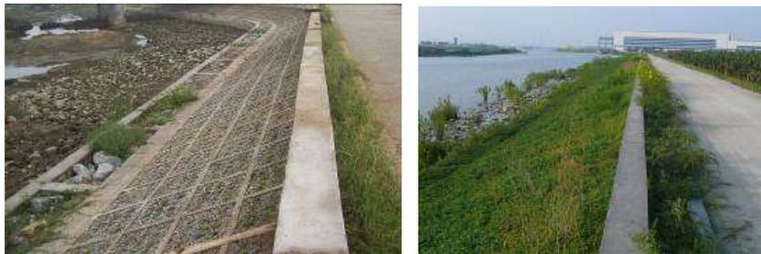
图 6-34 绿化混凝土护坡建成初期 绿化混凝土护坡建成一年后（缓坡）
