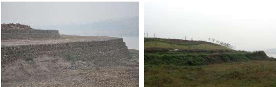
图 6-32 格宾石笼挡墙建成初期 格宾石笼挡墙植被自然恢复后
