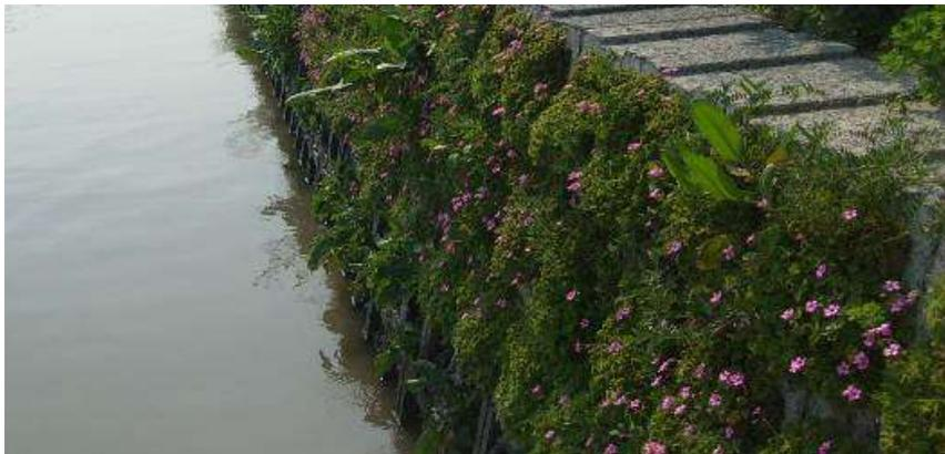
图 6-35 绿化混凝土护坡建成一年后（陡坡）
