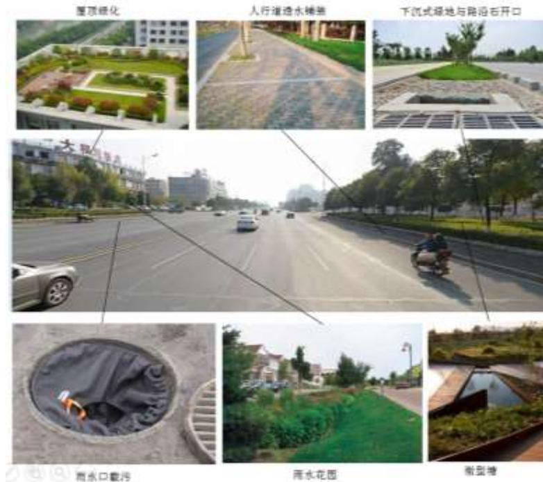
图 5-11 益阳大道海绵城市建设布设示意
