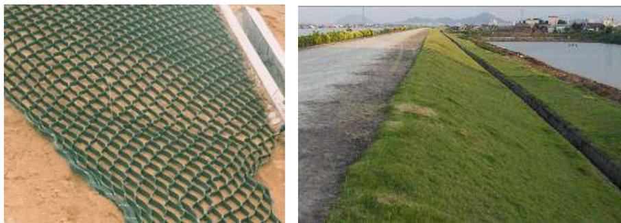
图 6-28 三维土工网施工现场 三维土工网草皮护坡建成后
