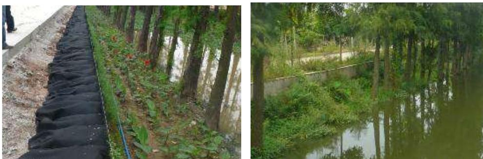
图 6-29 生态袋施工现场 生态袋植草护坡建成后
