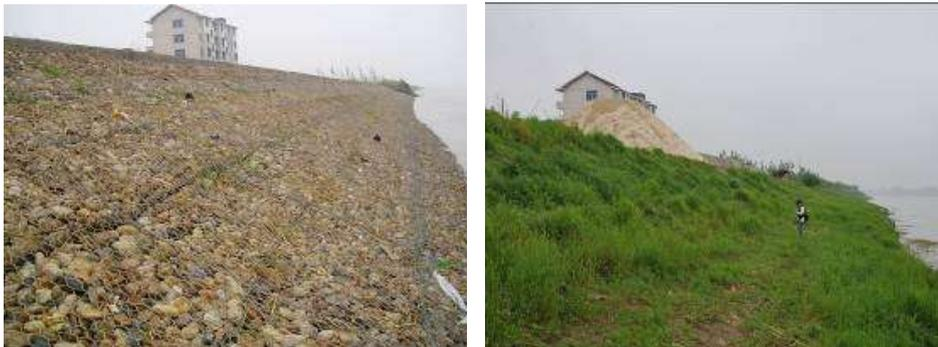
图 6-31 格宾护垫护坡建成初期
