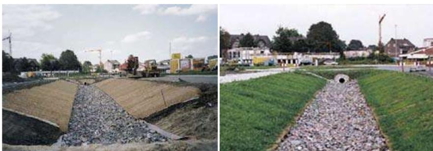
图 6-36 植物纤维毯护坡施工完成初期 植物纤维毯护坡复绿效果
