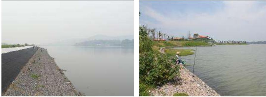
图 6-30 加筋麦克垫施工现场 加筋麦克垫护坡建成后
